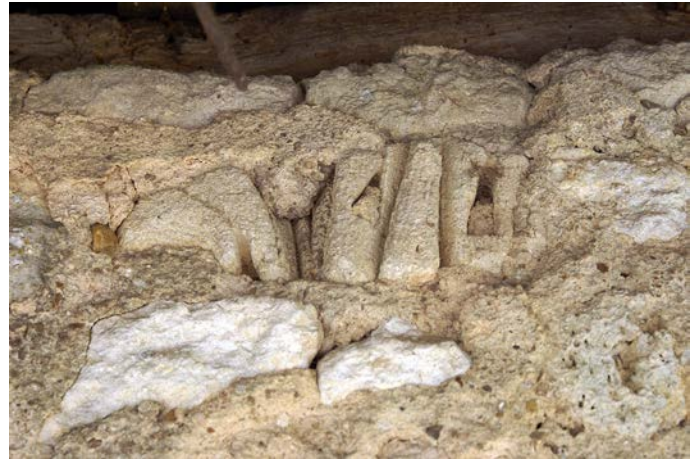
Fig. 40 – Moellon taillé à partir d'un chapiteau corinthien (cliché : S. Cormier, MADE-Département de l'Eure).
