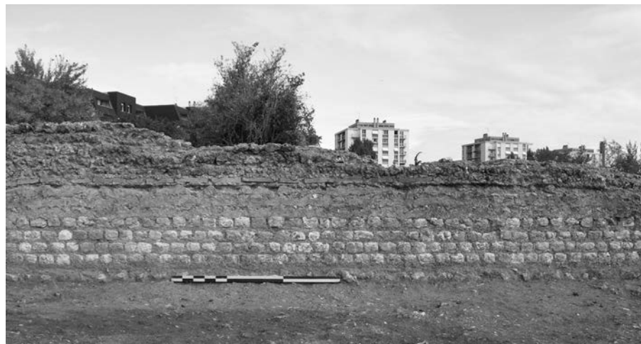
Fig. 9 – Parement sud du mur nord du pavillon d'angle nord-est avec un agencement différent dans la construction par rapport aux autres murs du sanctuaire (cliché : Br. Bazin, Service Archéologie de la ville de Chartres).
