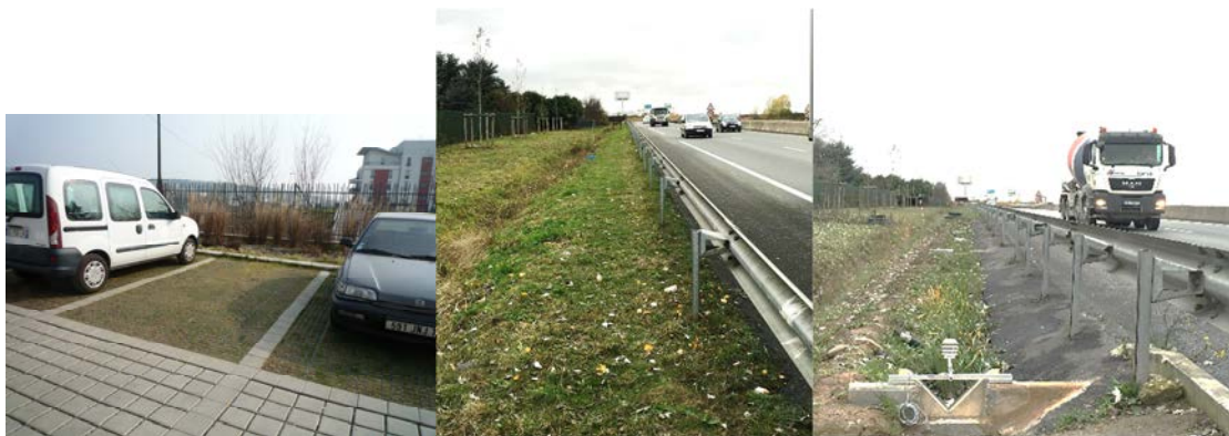
Figure 15. Ouvrages de gestion à la source des eaux de parking/voirie : parking perméable, bande enherbée, noue de biorétention (projet Roulépur)
