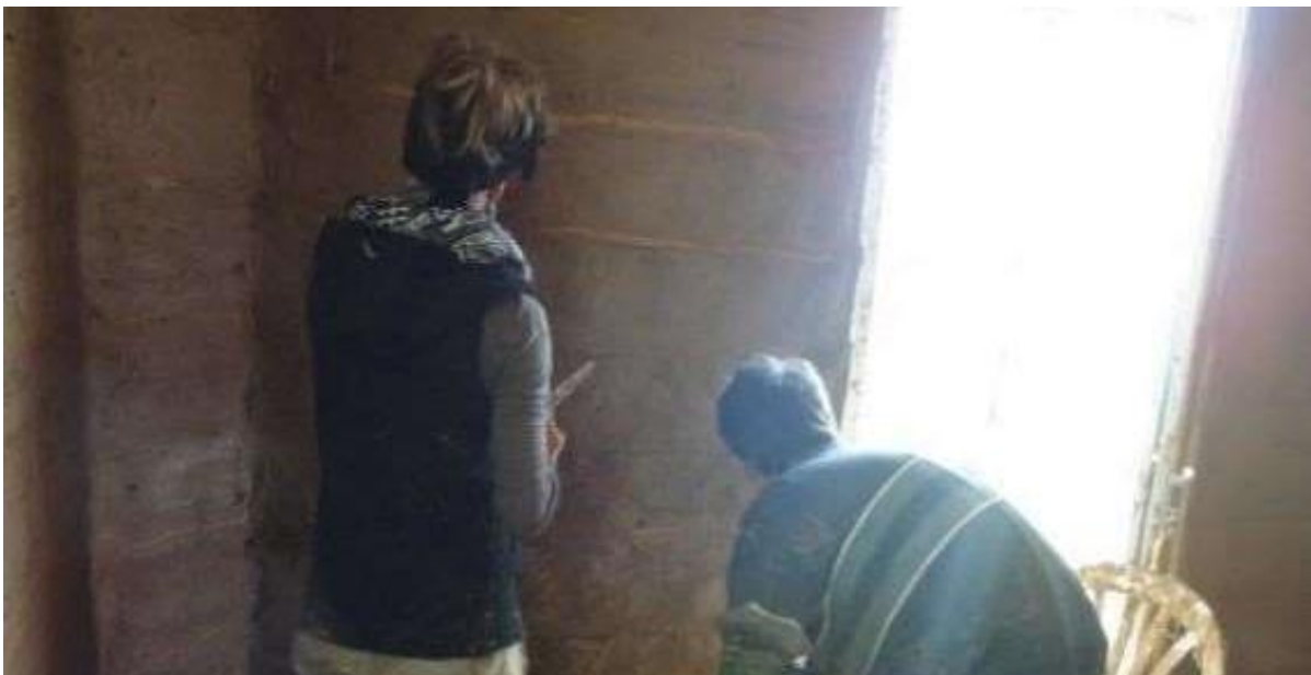
Auto-construction d'un bâtiment sur une microferme. Crédit photo : Kevin Morel.
