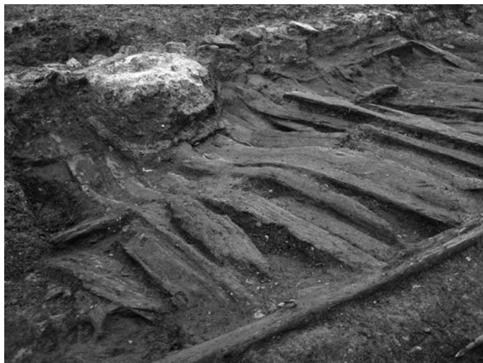
Fig. 14 - Soubassement de bois d'une chaussée de gravier dans le Waidmarkt, faubourg méridional de Cologne (cliché : A. Schäfer, Römisch-Germanisches Museum de Cologne).
