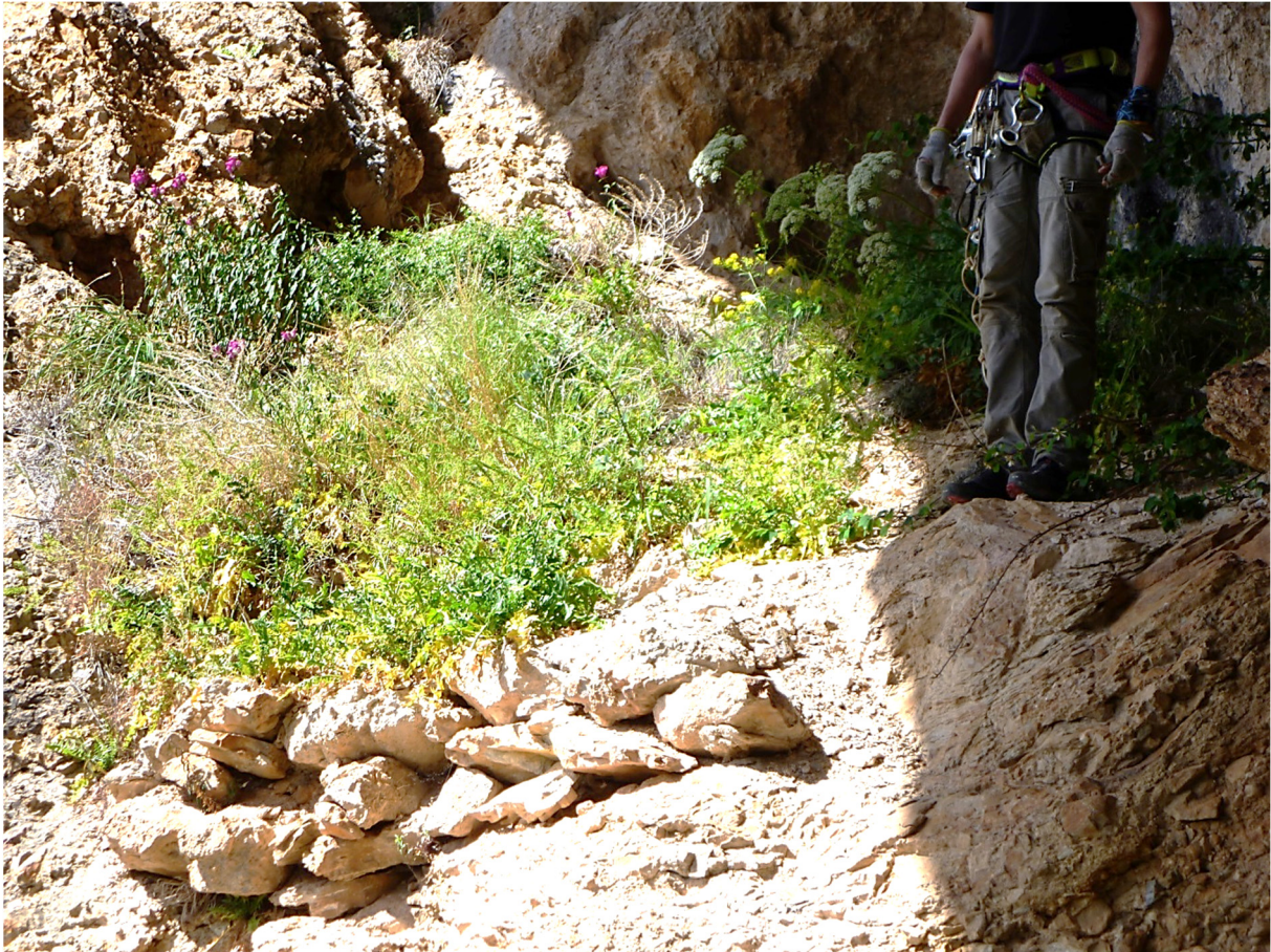
Mur de la terrasse supérieure.
