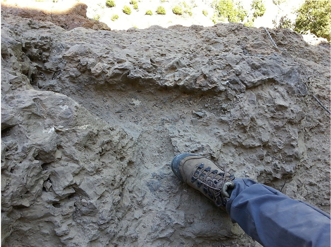
Fig. Porche nord-est, encoche longitudinale parallèle au vide.
