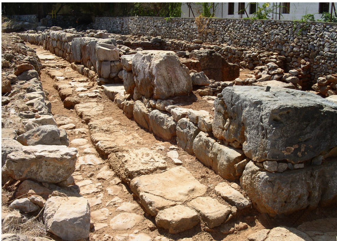
« Rue de la Mer », Malia (© Efa /M. Pomadère). Exemple de rue présentant un caniveau équipé d'un pavement irrégulier et un trottoir surélevé en dalles taillées.
