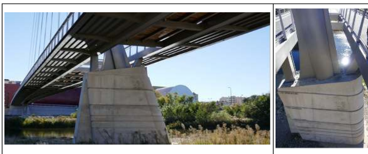
Figures 12 et 12bis. Hauteurs des crues selon leur période de retour sur une pile de la passerelle piétonne inaugurée en 2015 sur la Têt à Perpignan
