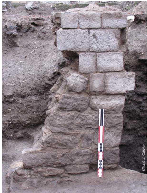
Fig. 10 - Vue en direction du sud de la façade de l'îlot au cours de la phase 1 (Cliché J. Ollivier).
