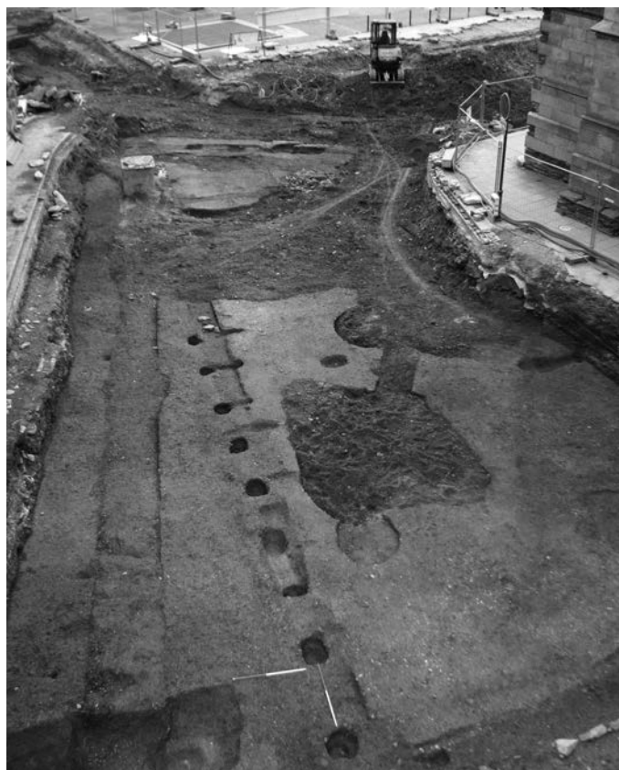
Fig. 10 – Construction augustéenne de la place Sainte-Anne vue vers le sud (cliché : H. Paitier, Inrap).
