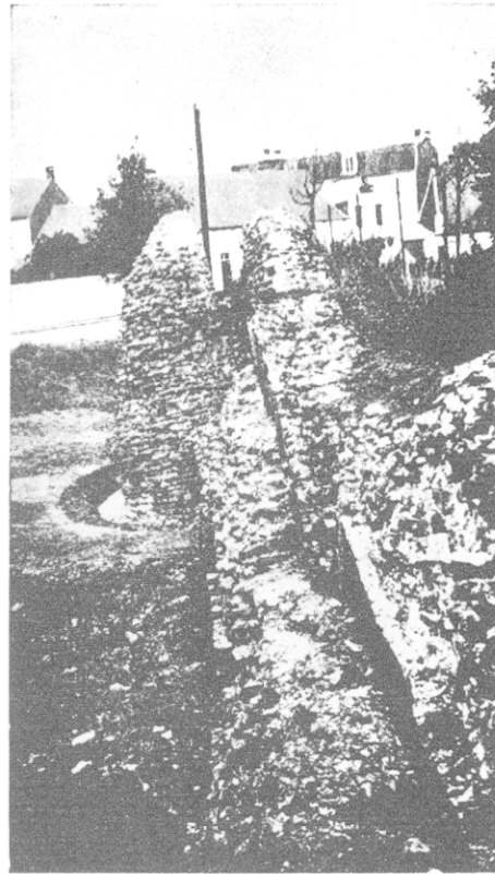
FIG. 3. La courtine O. et la tour 4 vues de la tour 5.
