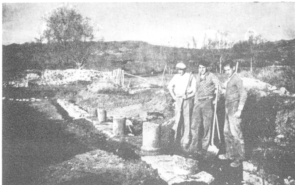
FIG. 13. Portique BF des thermes des femmes. Les ouvriers sont occupés à déblayer l'esplanade BJ sur laquelle donnait le portique et qui précédait à l'est la façade du « temple de source ».
