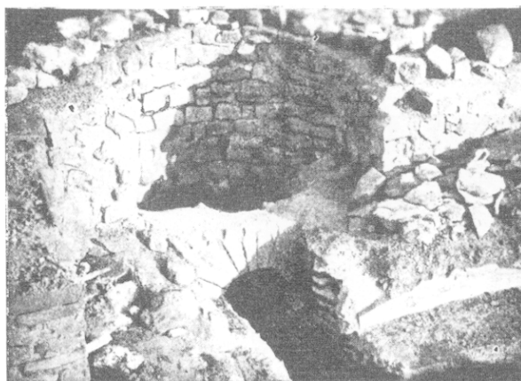
FIG. 6. Arc de décharge du 1 er siècle qui abritait un tuyau de plomb pour la vidange de la piscine froide RUZ. (Voyez un autre arc similaire et de même date au centre de la figure 5.)
