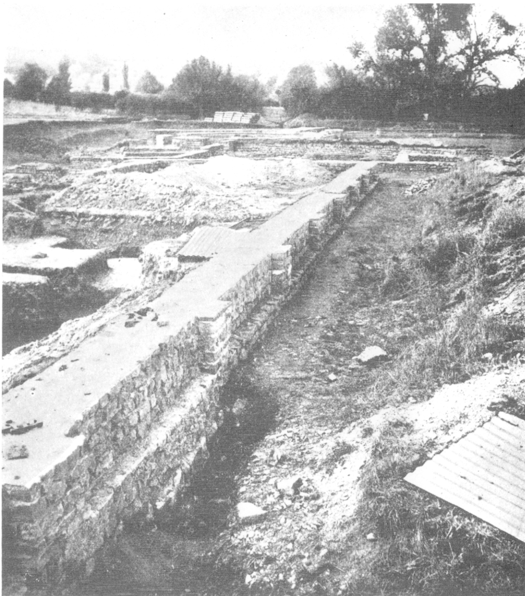
FIG. 17. La façade à pilastres du vestibule BA ; à l'intérieur, une tranchée montre en coupe le béton blanchâtre posé sur un lit de pierres en hériss.
