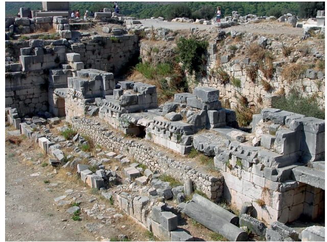
Fig. 4. Le bâtiment de scène, vue du Sud-Ouest, état actuel.
