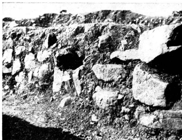
Fig. 7. — Vue oblique du mur D.
