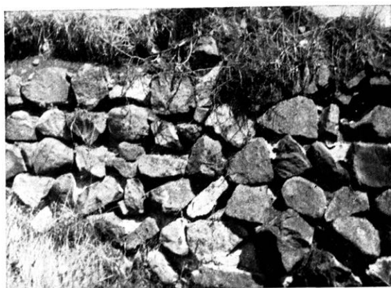
Fig. 9. — Type de mur maçonné (mur Est de la pièce M).
