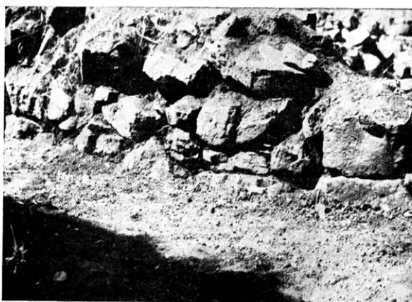
Fig. 8. — Vue du mur C.
