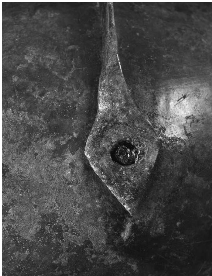
Fig. 8 – Détail de fixation d'un renfort par un rivet de fer (cliché : J.-L. Bellurget).
