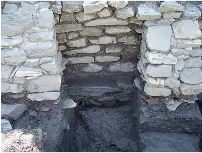
Fig. 8 – Vue des contreforts (cliché : S. Crogiez-Pétrequin, Université de Tours, 2006).
