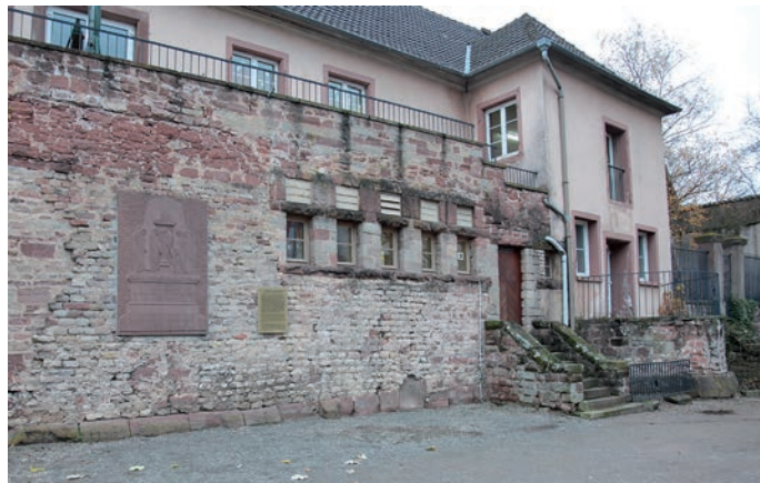
Fig. 7 – Détail de l'élévation de la courtine de l'enceinte tardive à Tabernis-Tres Tabernae (cliché : N. Meyer, Inrap).
