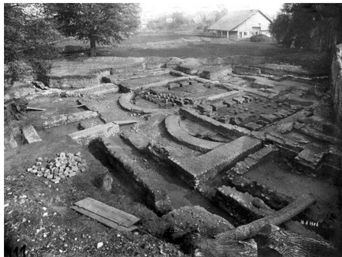
Fig. 14 – Yverdon-les-Bains : vue de la fouille des thermes du castrum en 1906 (cliché : archives cantonales vaudoises).
