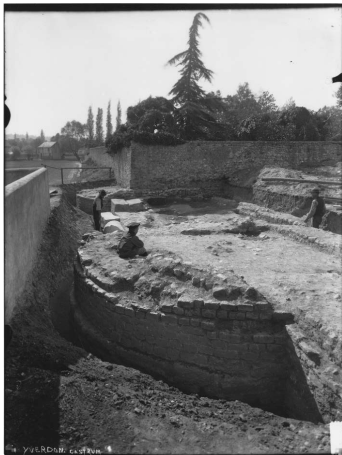
Fig. 13 – Yverdon-les-Bains : vue de la fouille de la porte de l'Est du castrum en 1906 (cliché : archives cantonales vaudoises).
