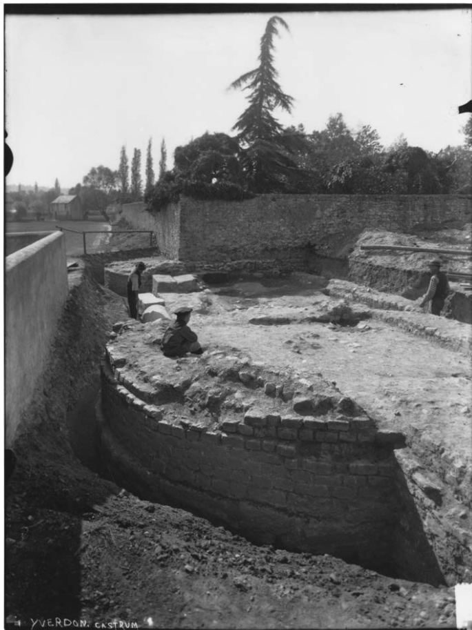
Fig. 13 – Yverdon-les-Bains : vue de la fouille de la porte de l'Est du castrum en 1906 (cliché : archives cantonales vaudoises).
