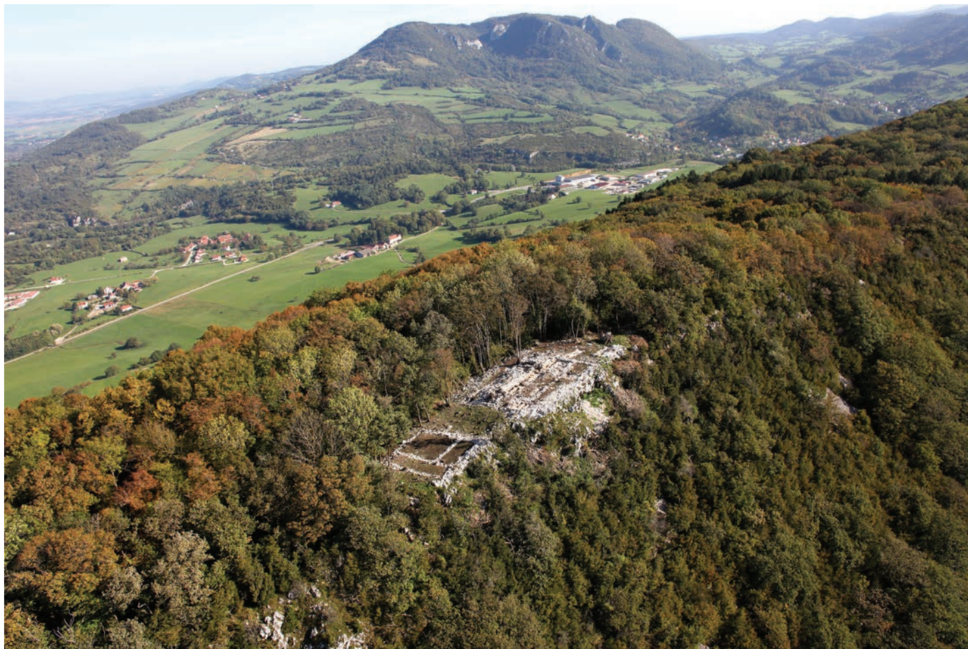
Fig. 6 – L’habitat sur solins et l’église implantés en bordure de falaise (cliché : Com’Air).
