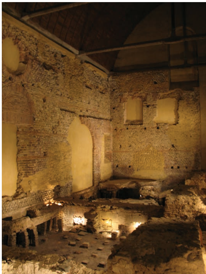
Fig. 7 – Thermes romains ayant servi de support à la construction, au haut Moyen Âge, de l'église Saint-Étienne d'Entrammes (Mayenne) (cliché : M. Monteil, université de Nantes, UMR 6566 CReAAH).
