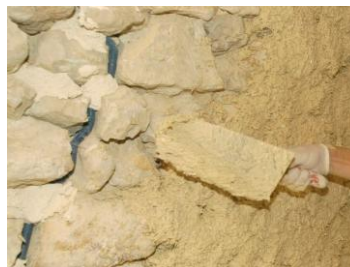
Figure 3: Correcteur thermique (800 – 900 kg/m 3 )
