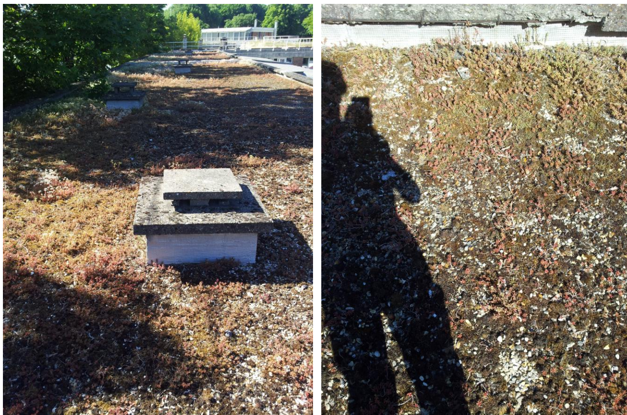
Figure 6. Aperçu de la toiture témoin en Juin 2013.
