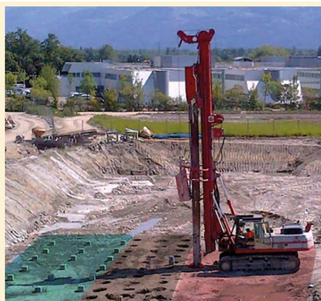
Figure 4. Métamatériau sismique en sol troué : une source vibre à 50 Hz, et génère des ondes de surface (de Rayleigh) réfléchies par un réseau de trous de 0,3 m de diamètre, 5 m de profondeur, espacés de 1,7 m (distance de centre à centre) grâce à l'existence d'une bande interdite autour de 50 Hz.
