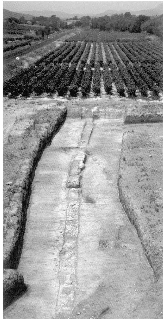
Fig. 124 – Villa de Vareilles : vue du segment 1 et de la fondation du premier aqueduc bas en direction de l'amont (cliché S. Mauné, CNRS).
