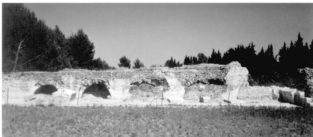
Fig. 89 – Les arches 1-5 de la section amont du pont-aqueduc de Barbegal à Fontvieille (cliché P. Foliot, CNRS).
