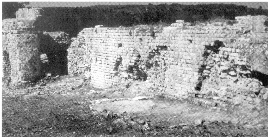
Fig. 88 – Culée aval du parement ouest du pont-aqueduc de Barbegal à Fontvieille (cliché P. Leveau, CNRS).
