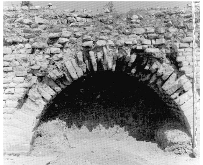
Fig. 90 – Pont-aqueduc de Barbegal à Fontvieille : détail de l'arche B1-B2 (cliché P. Leveau, CNRS).
