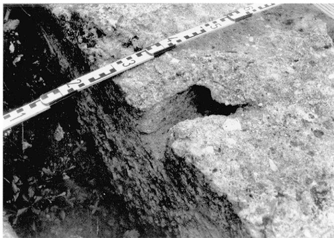
**Fig. 55** – Trou de logement de crampon de bois reliant deux blocs de grand appareil de la culée amont du pont de Font Ménéstière. La cavité était recouverte par un opercule de mortier de chaux qui portait, en négatif, les traces du sciage du crampon de bois (cliché J.-L. Paillet, CNRS).
