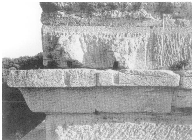
**Fig. 64** – Vue de la retombée d'une arche du 3<sup>e</sup> étage du Pont du Gard. Deux cavités coudées creusées dans des bossages d'un sommier, sur son lit de pose, sont en relation avec deux autres cavités verticales creusées dans le lit d'attente d'une imposte moulurée en corniche. Ces deux dernières ont été tronquées lors du ravalement antique de la corniche (cliché J.-L. Paillet, CNRS).
