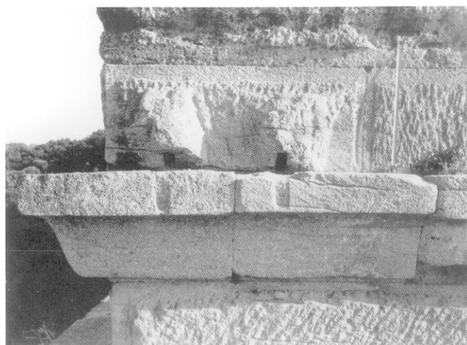
Fig. 64 – Vue de la retombée d'une arche du 3 e étage du Pont du Gard. Deux cavités coudées creusées dans des bossages d'un sommier, sur son lit de pose, sont en relation avec deux autres cavités verticales creusées dans le lit d'attente d'une imposte moulurée en corniche. Ces deux dernières ont été tronquées lors du ravalement antique de la corniche (cliché J.-L. Paillet, CNRS).
