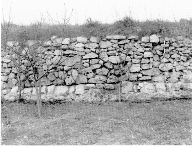
Fig. 33 – La Fiau , tronçon de l'aqueduc conservé à la base d'un mur de terrasse moderne (présence d'un regard) (cliché I. Bermond, SRA Languedoc-Roussillon).
