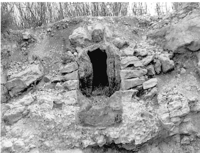
Fig. 6 – Aqueduc d'Antipolis, vallon de la Bouillide, chantier Euréka : coupe du canal maintenant sous l'immeuble Solaris (cliché et DAO P. Garczynski et J. Fourcas, CNRS).
