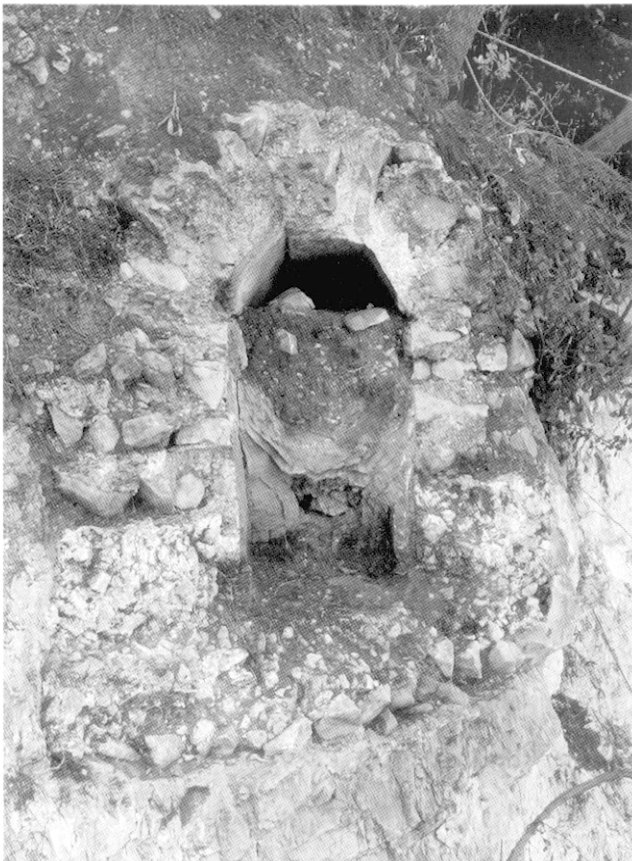
Fig. 27 – Aqueduc d'Antipolis, coupe du canal du chemin du Puy, résidence les Comores (cliché P. Garczynski, CNRS).
