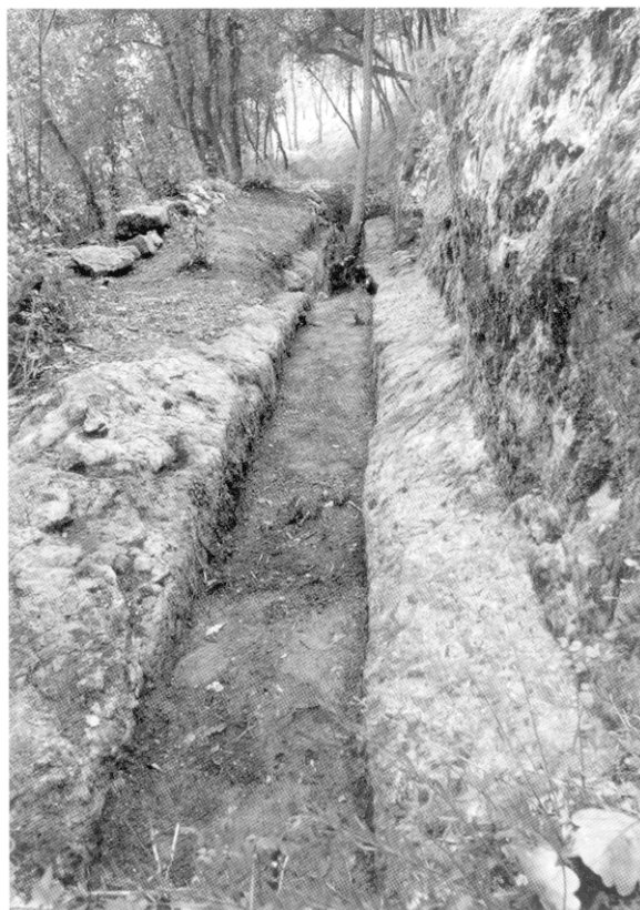
Fig. 4 – Aqueduc d'Antipolis, vallon de la Bouillide : canal taillé dans la roche (cliché P. Garczynski, CNRS).
