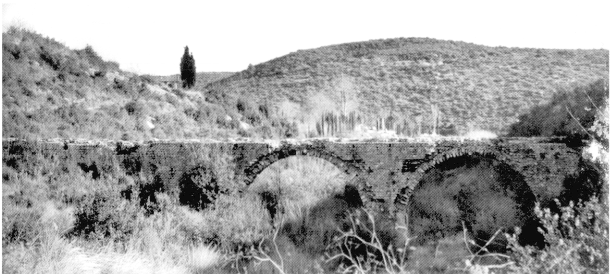
Fig. 13 – Aqueduc d'Antipolis, le pont de la Valmasque, vue générale (cliché M. Greenwood, vers 1950).
