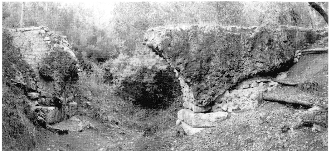
Fig. 9 – Aqueduc d'Antipolis, vue générale du pont à une arche en élévation. On remarque la limite inférieure des concrétions externes qui donnent le profil du talus à l'époque romaine (cliché P. Garczynski, CNRS).
