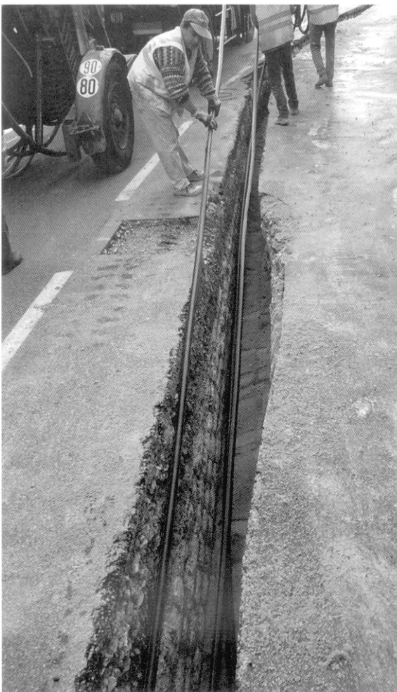
Fig. 15 – Aqueduc d'Antipolis, chemin des Trois-Moulins : dépose de câbles de fibres optiques dans le canal romain (cliché P. Garczynski, CNRS).
