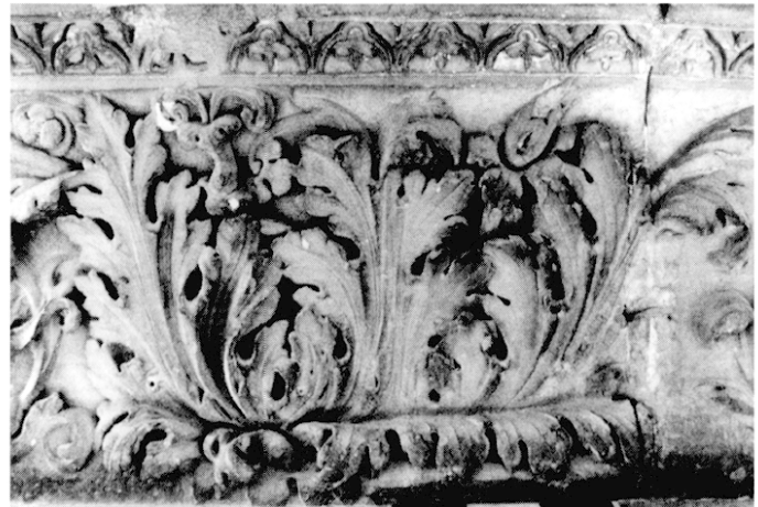
Fig. 19 – Exemple d'élément sculpté très finement en pierre des Lens : le motif axial de la frise de la Maison Carrée à Nîmes (photo J.-C. Bessac, CNRS).
