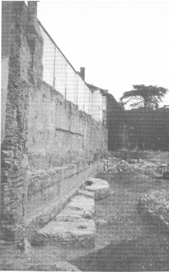
Fig. 5 — Les fondations de la tour et du départ de la courtine abandonnées après correction du tracé de l'enceinte.
