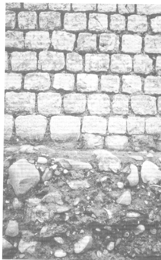
Fig. 13 — Apport d'une assise supplémentaire de moellons à la base du soubassement.
