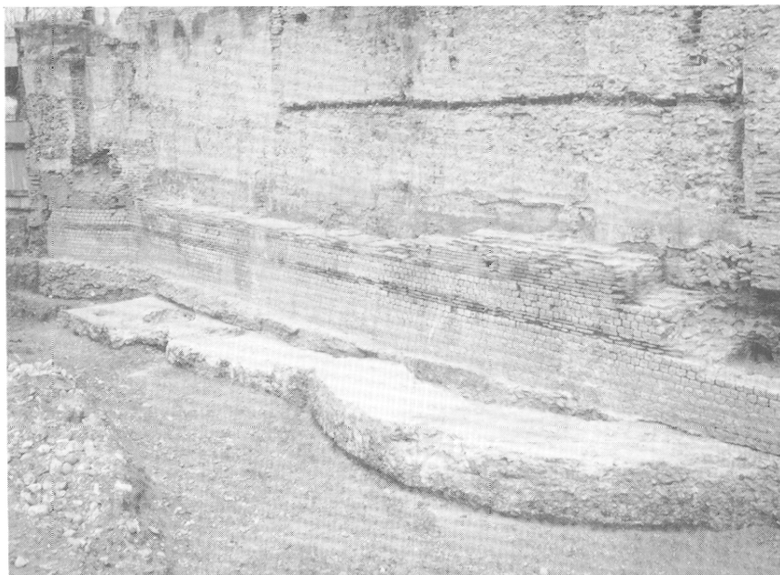
Fig. 6 — Les fondations abandonnées et la réalisation effective.
