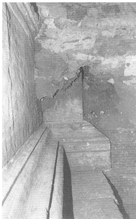
Fig. 10 — Arles au Haut Empire (cf. fig. 6, 48). Vestiges d'un espace public, dans une cave, rue Truchet.
