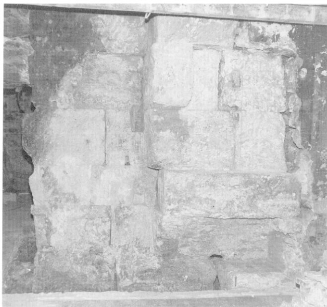
Fig. 2 — Arles protohistorique (cf. fig. 1. 1). Mur en grand appareil, à bossage, dans une maison, le long du Rhône.
