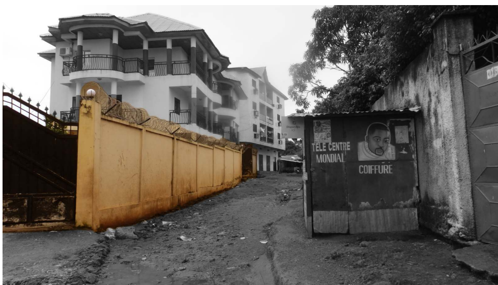
Photo 3. Un mur de clôture à Hafia mosquée
