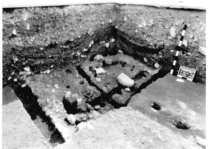
Fig. 33 – Carrés 35/36 d'Oedenburg-Altkirch : vue depuis le nord-est sur les fondations coulées (US 350/1110) avec trous des piquets et négatifs des poutres du radier horizontal (cliché G. Seitz, univ. de Fribourg-en-Brigau).
