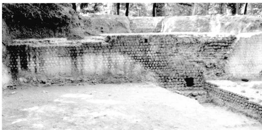
Fig. 54 – Péribole nord, drain à l'est de l'escalier 6.
