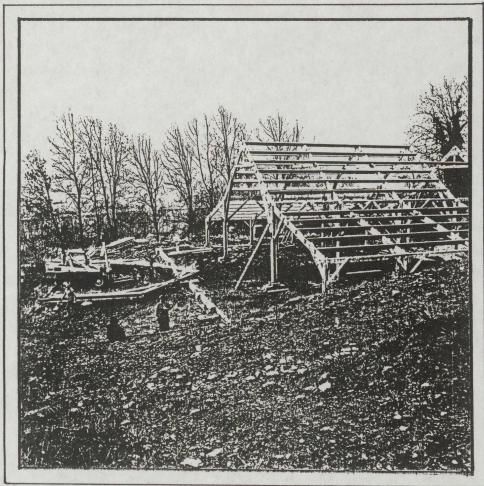
TRAVEE EN PORTIQUES DE LA CHARPENTE
