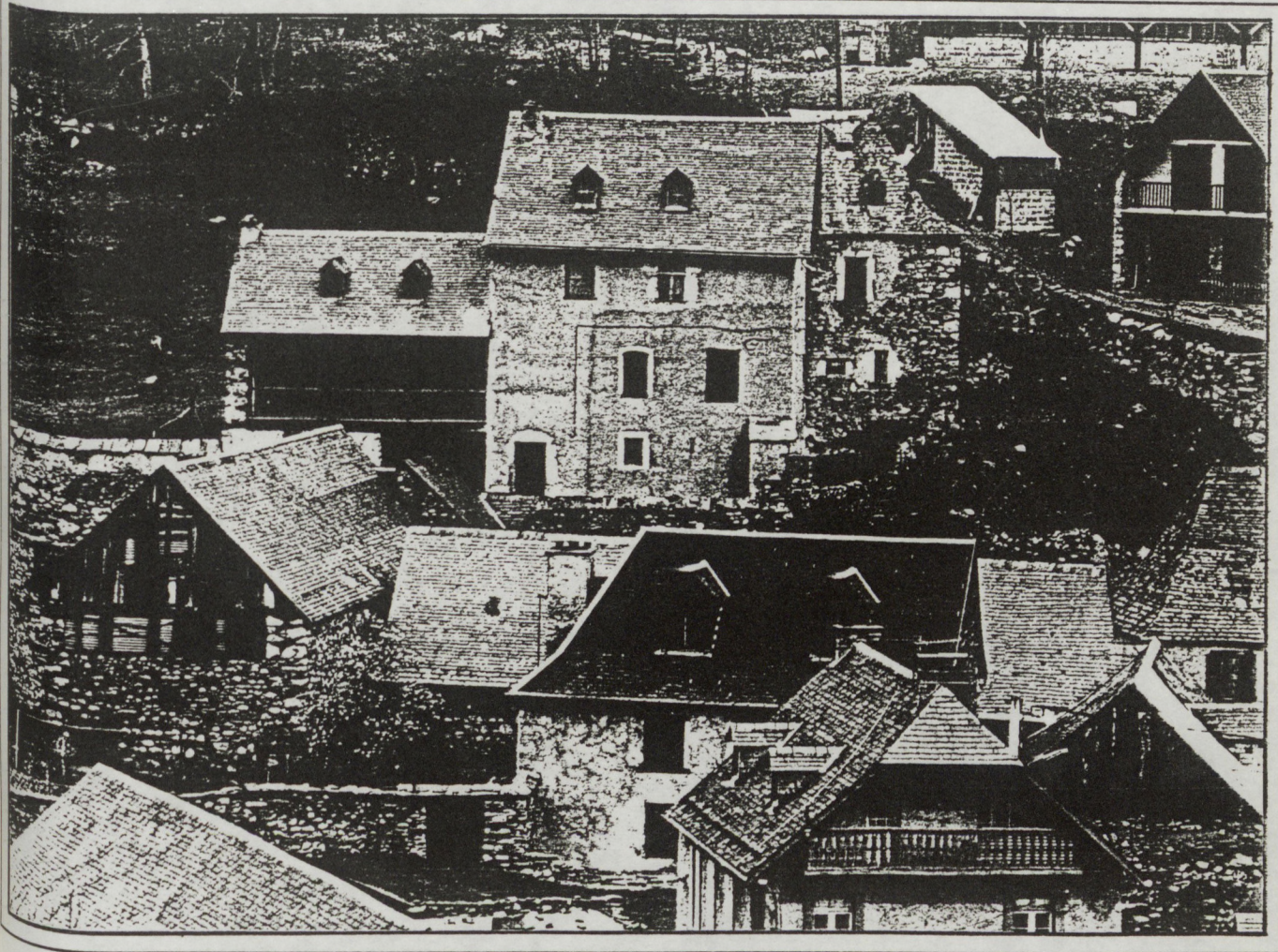
MAISON BLOC AVEC ENSOLEILLADE (village d'Oo)
