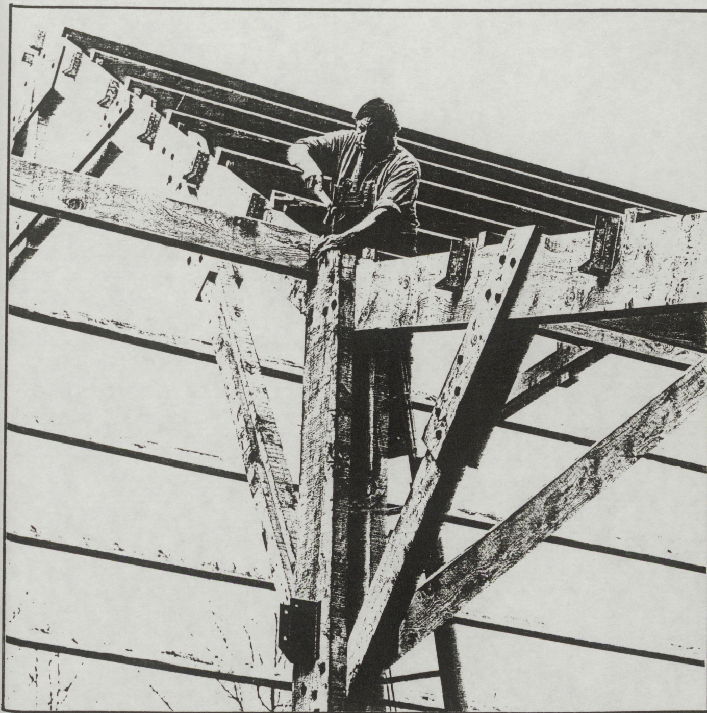
ASSEMBLAGES SIMPLES EN MOISAGE ET BOULONNAGE
