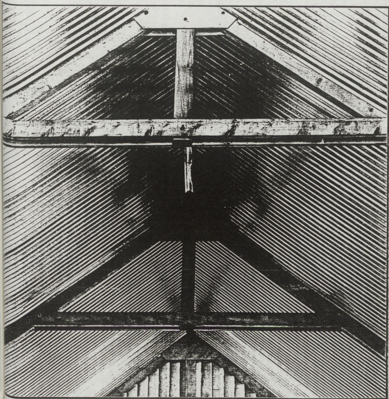
VENTILATION HAUTE ET SOUS-FACE DE L'ISOLATION.
