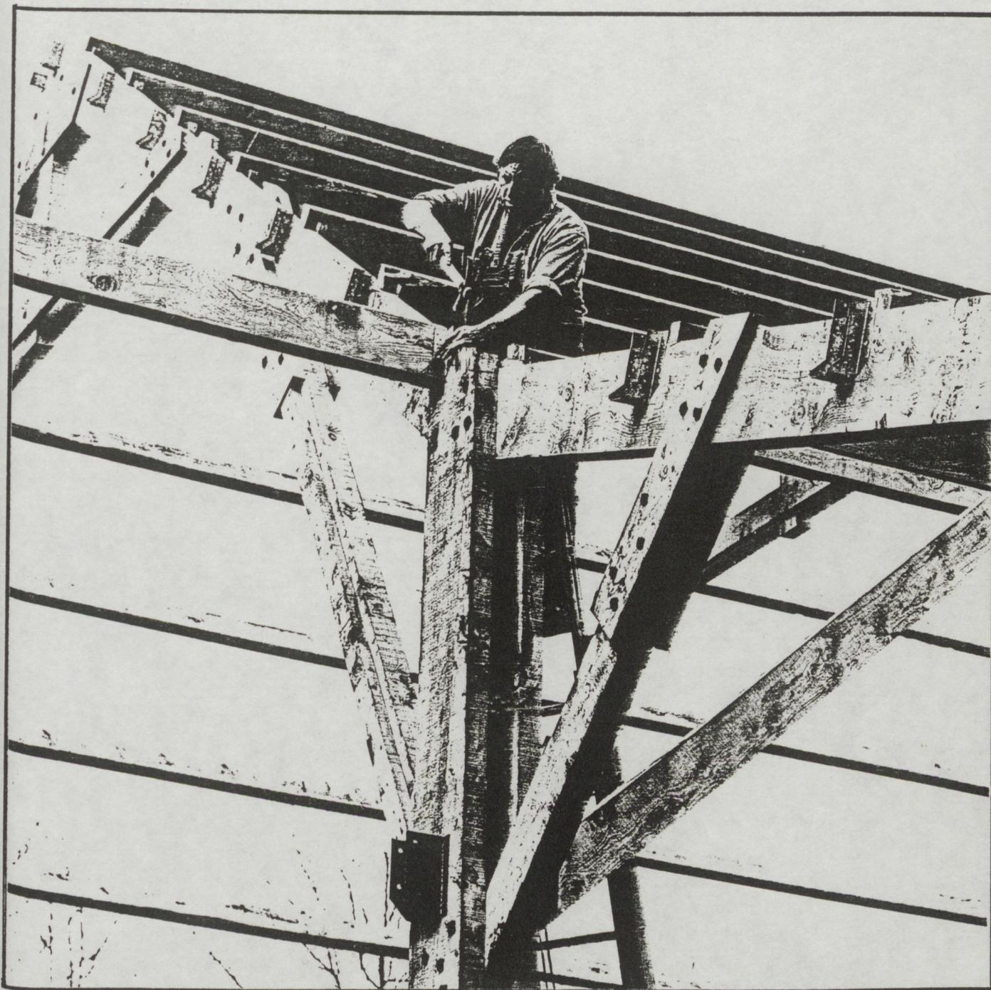
ASSEMBLAGES SIMPLES EN MOISAGE ET BOULONNAGE
