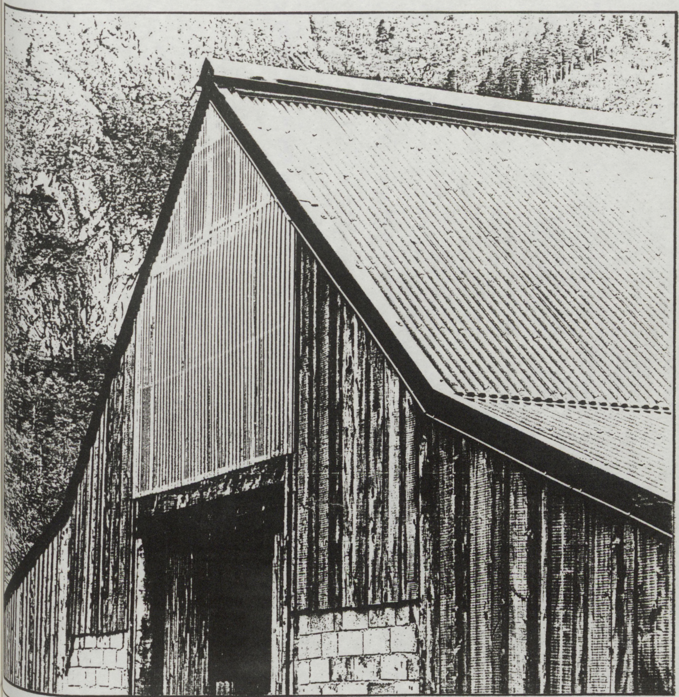
INFLEXION DE LA TOITURE ET FAITIERE VENTILEE.
