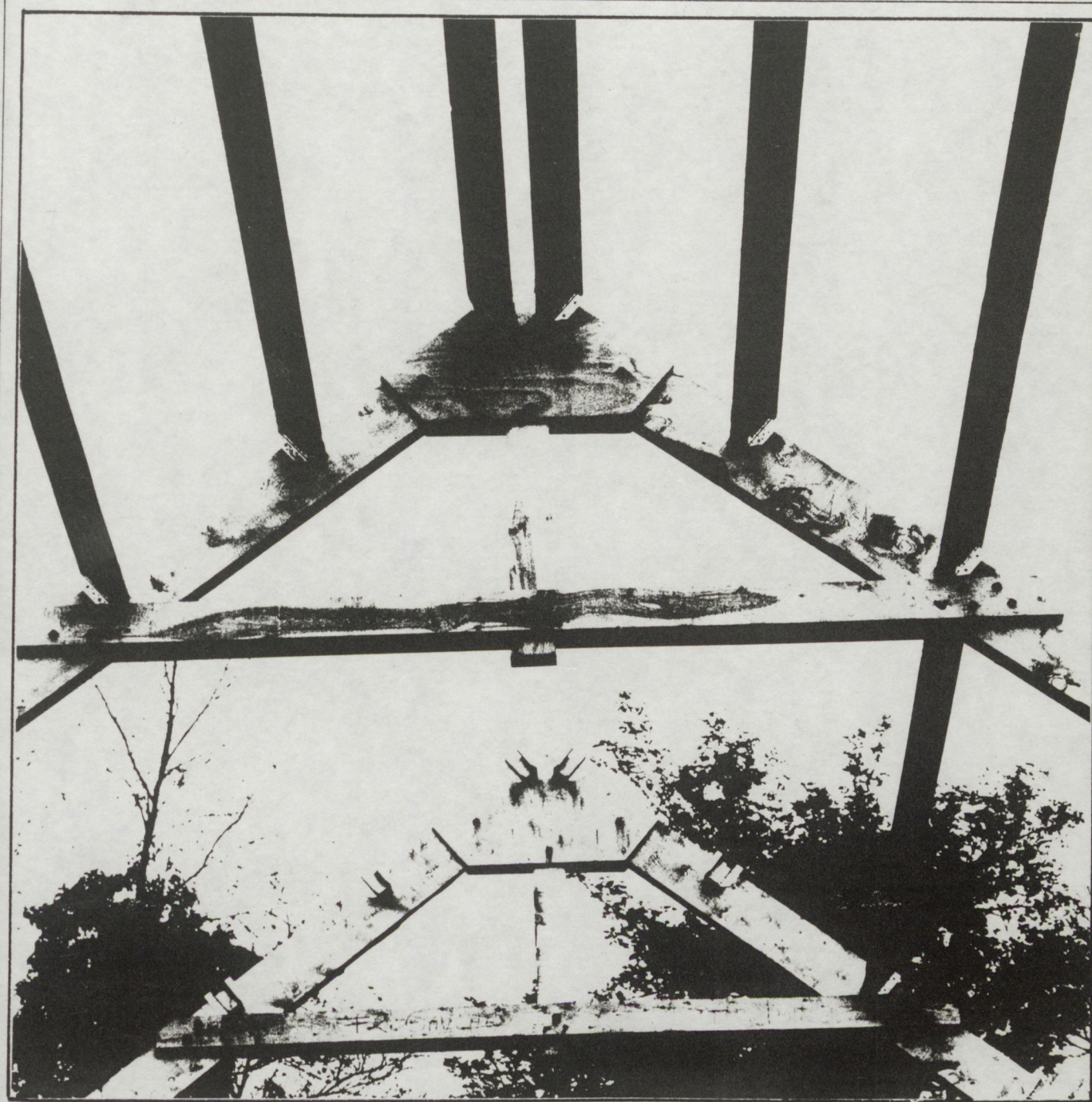
DES ASSEMBLAGES SIMPLES . Moilage et boulonnage
