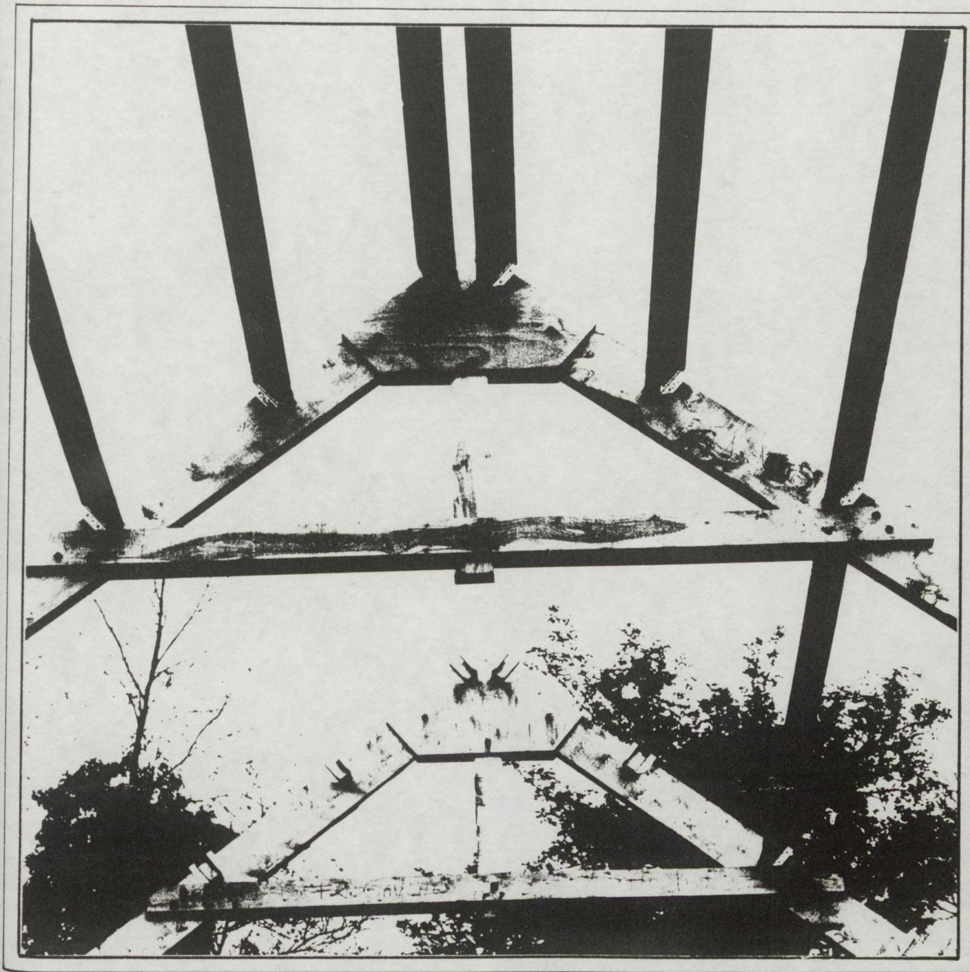
DES ASSEMBLAGES SIMPLES . Moilage et boulonnage
