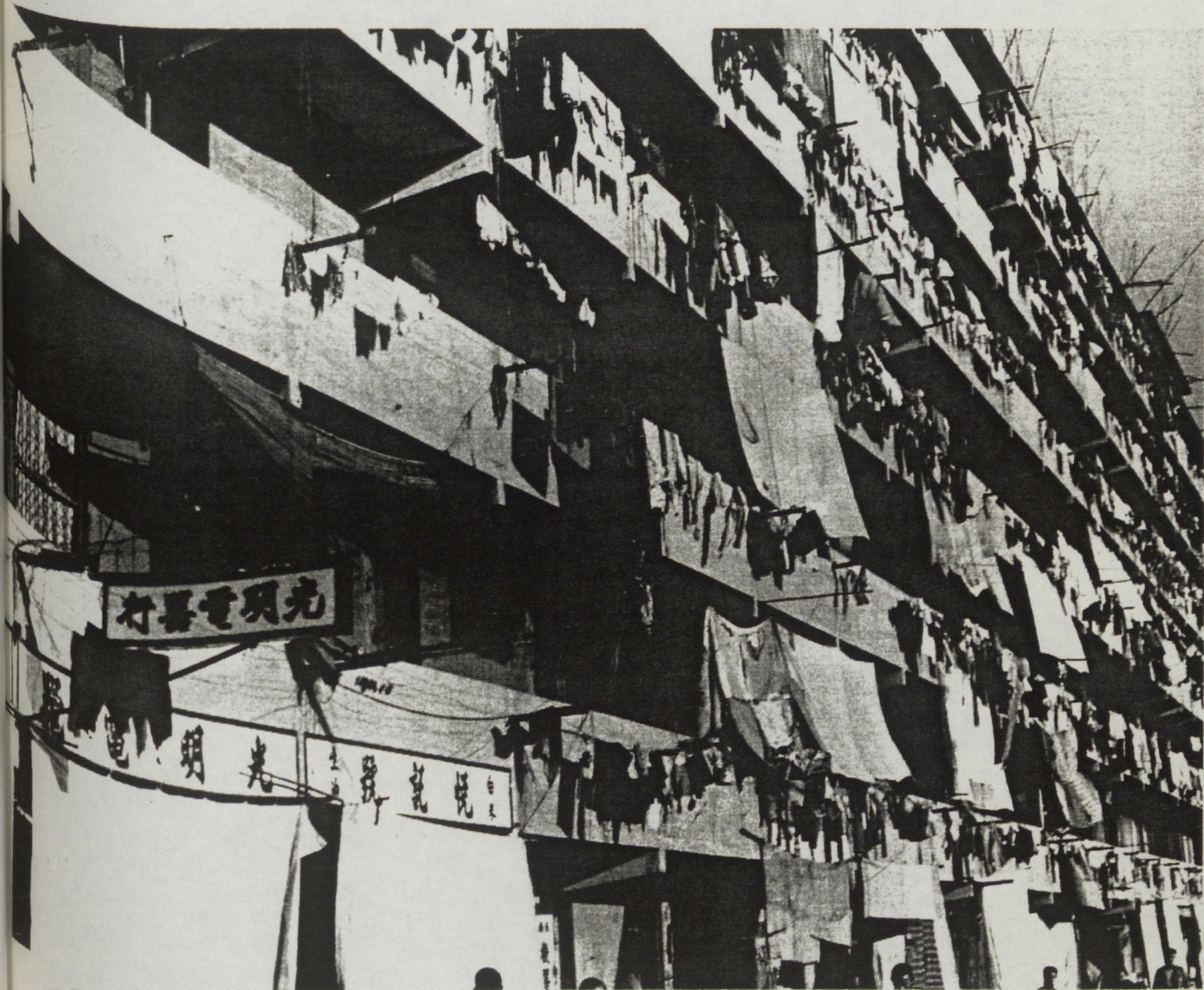
P1.8. Un immeuble construit pour les réfugiés chinois à Kowloon, Hong Kong, 1960. Photo UNESCO / Cart 1962
