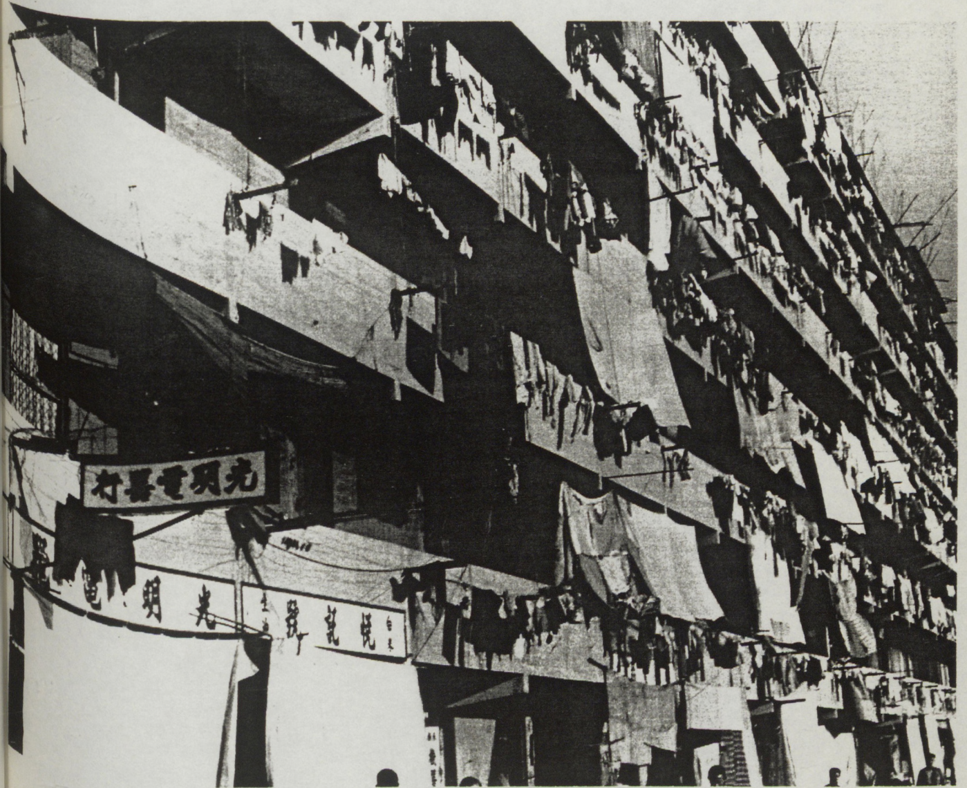
P1.8. Un immeuble construit pour les réfugiés chinois à Kowloon, Hong Kong, 1960. Photo UNESCO / Cart 1962
