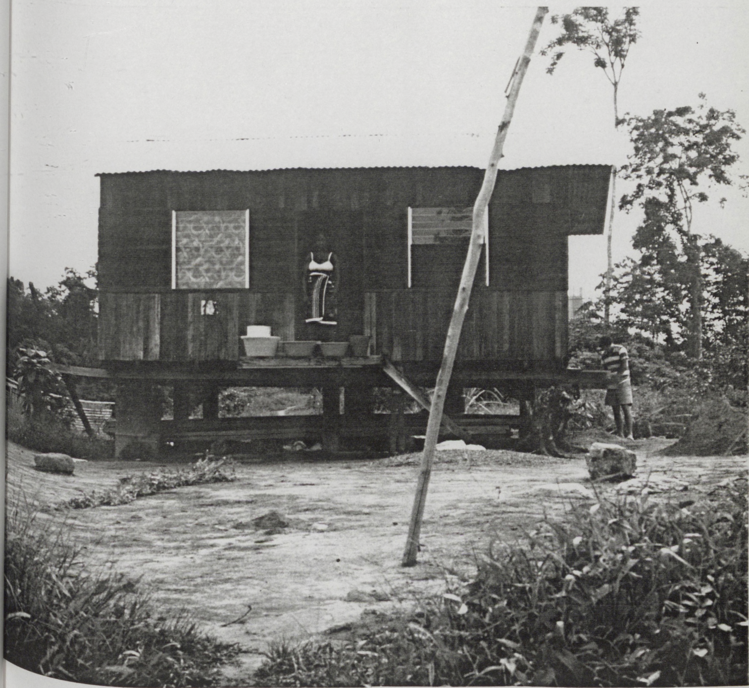
Pl. 3. Maison Marronne moderne dérivée de la case créole - Les débords de plancher doivent servir à édifier une galerie circulaire, ultérieurement. Photo A.H. Apatou 1980.
