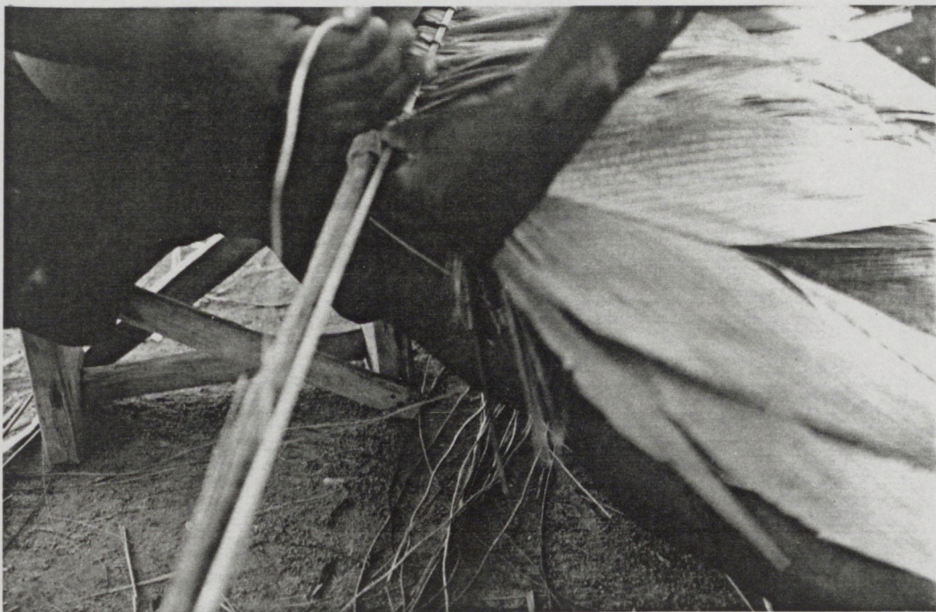
Pl. 2. Techniques de la constructions traditionnelle - A. Charpente mortaisée supportant une toiture en feuilles de palmier. B. Confection d'une rame de feuilles de palmiers pour la réalisation d'une toiture traditionnelle. Photos A.H. Apatou 1980.
