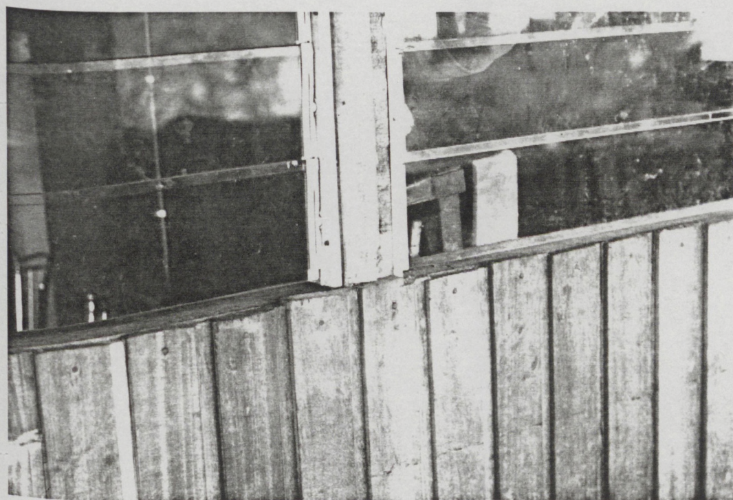
Pl. 3. Détails de mise en oeuvre des constructions modernes - A. Charpente en bois de scierie cloué et tôle B. Chassis ouvrants en lamelles de verre et aluminium. Photos A.H. La Charbonnière 1981.
