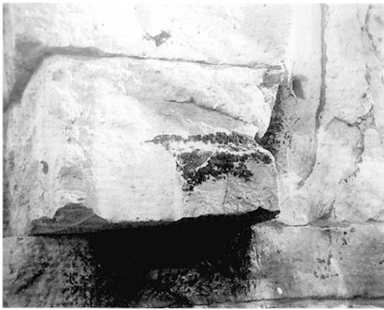
**Fig. 15** – Détail de la partie haute de la face postérieure de la porte de France, côté est. Surface plane en saillie augmentant la profondeur de la panneresse inférieure à l'extrémité du mur aveugle (photo P. Varène, CNRS).
