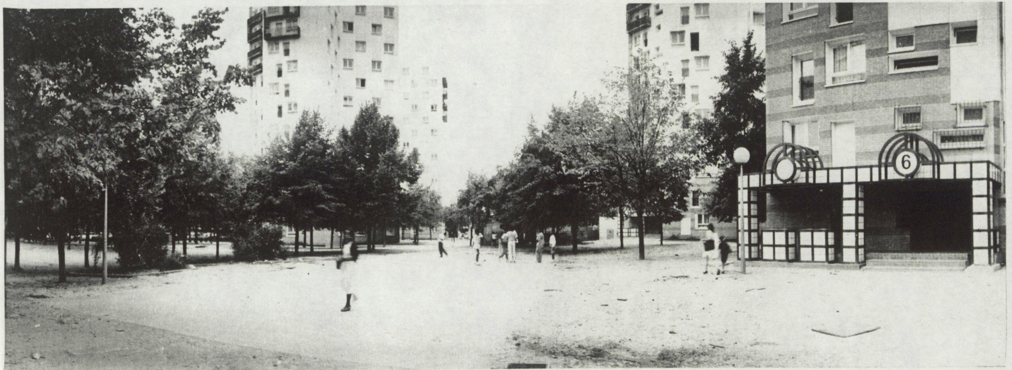
Grand ensemble à Aubervilliers
