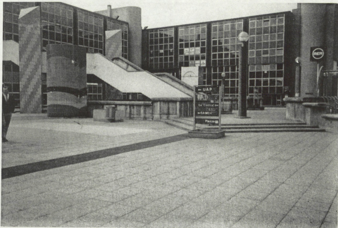
Place du Centre à Noisy Le Grand
