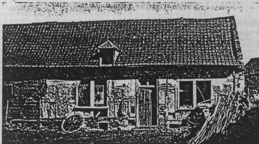
Ancienne habitation en torchis : ossature de bois et remplissage en terre mélangée de bourre ou de paille hachée. Saint-Sauveur, près du Boeuel.
