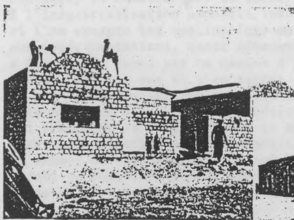
Maisons en toub (agglomérée en béton de terre), à DJORF, village d'oléiculteurs du HADNA (Algérie). Maisons en cours de construction.
