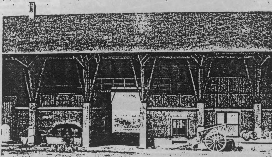
Vue montrant les travées du bâtiment d'exploitation de la ferme Queemel.
