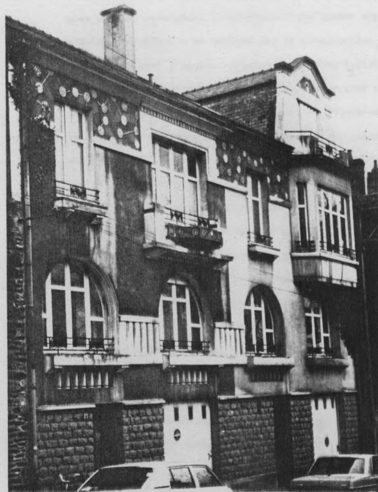
1932 - 13-15 rue Saint-Martin à Rennes (Prévos entrepreneur)
