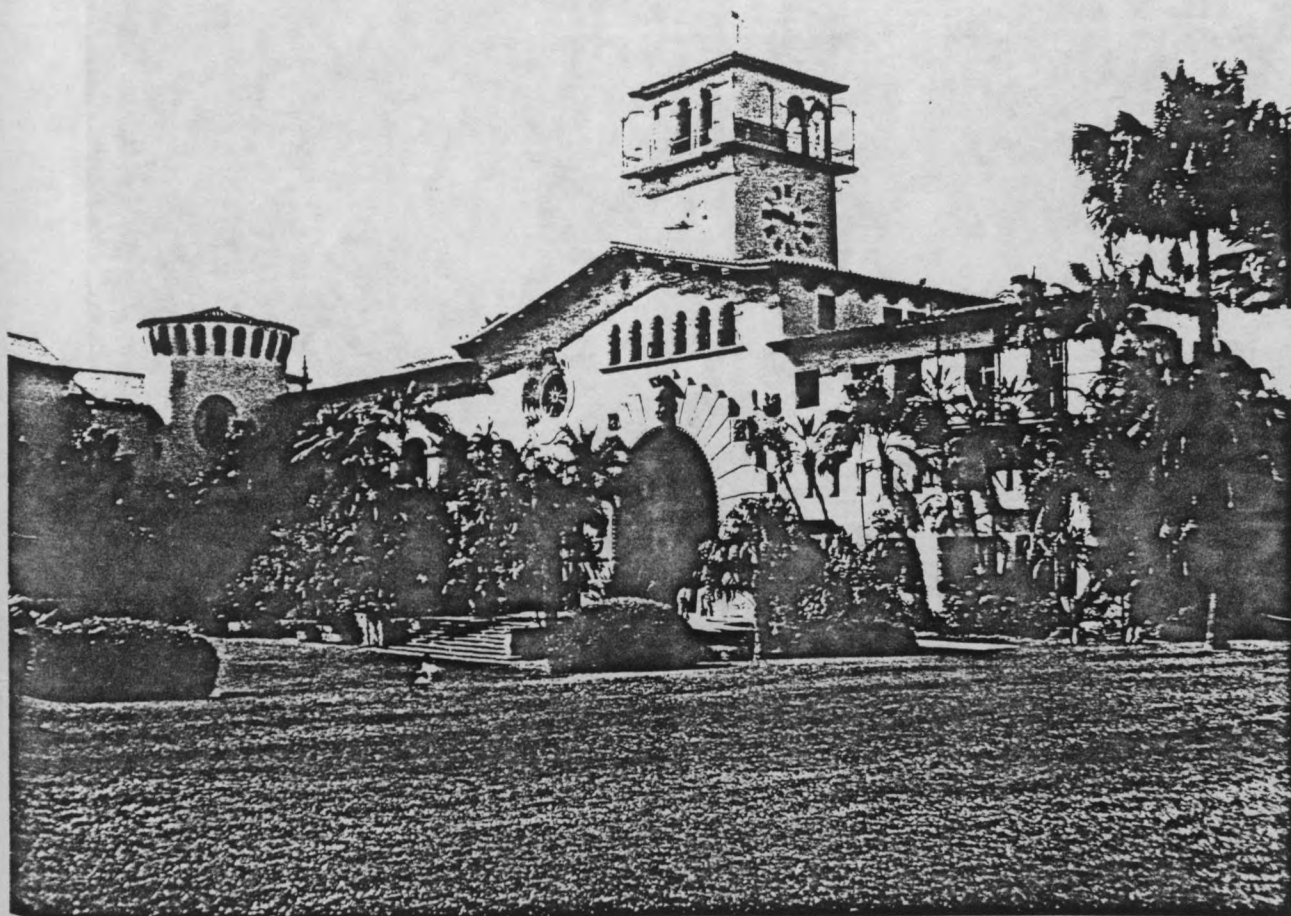
Palais de justice de Santa Barbara (W. Mooser et Co, architectes; 1929). Photo. D. Treiber.
