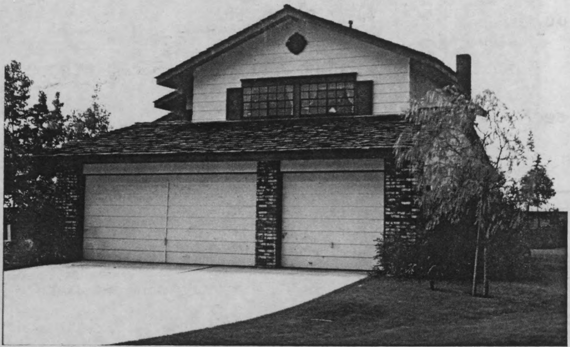
Maison individuelle avec un garage 3 places, façade sur rue . Orange County .
